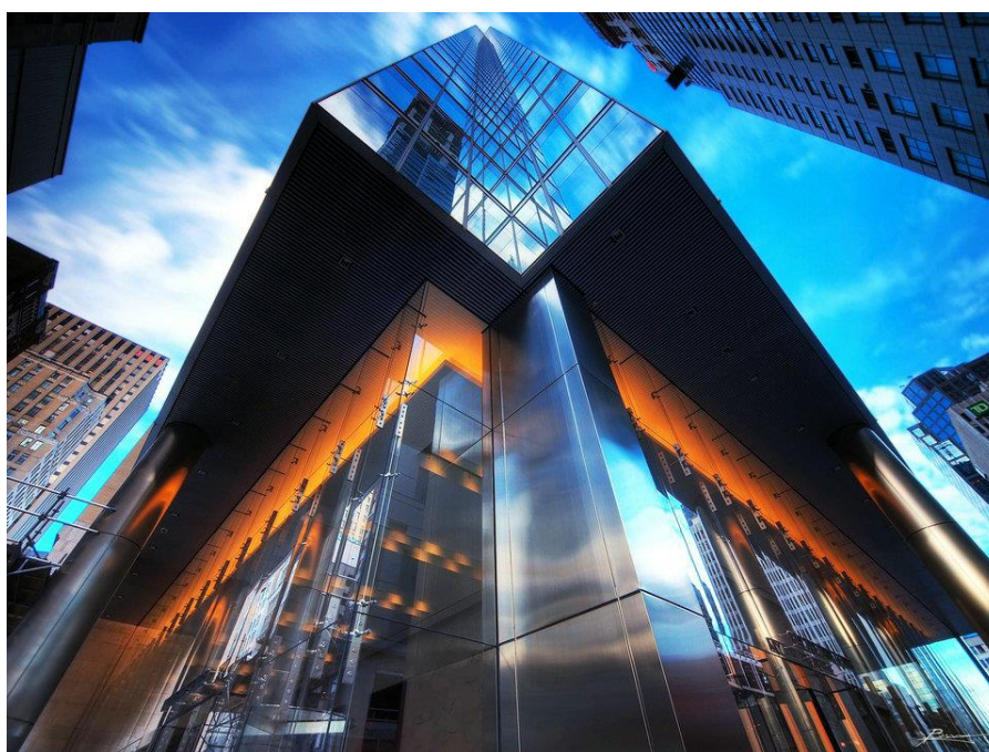
Imagem 20 - Exemplo de edificação Neomoderna
