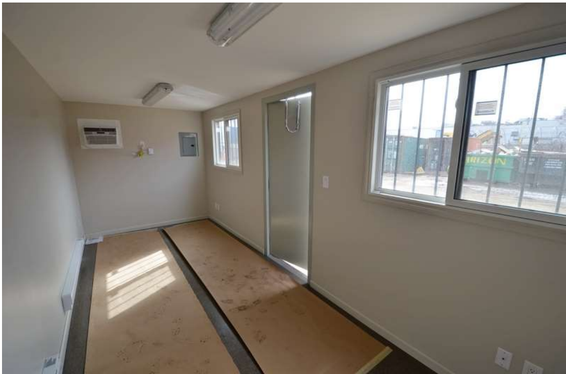
Imagem 08 - Fechamento em forro de gesso
