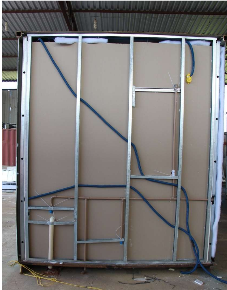
Imagem 06: Instalação hidráulica container.
